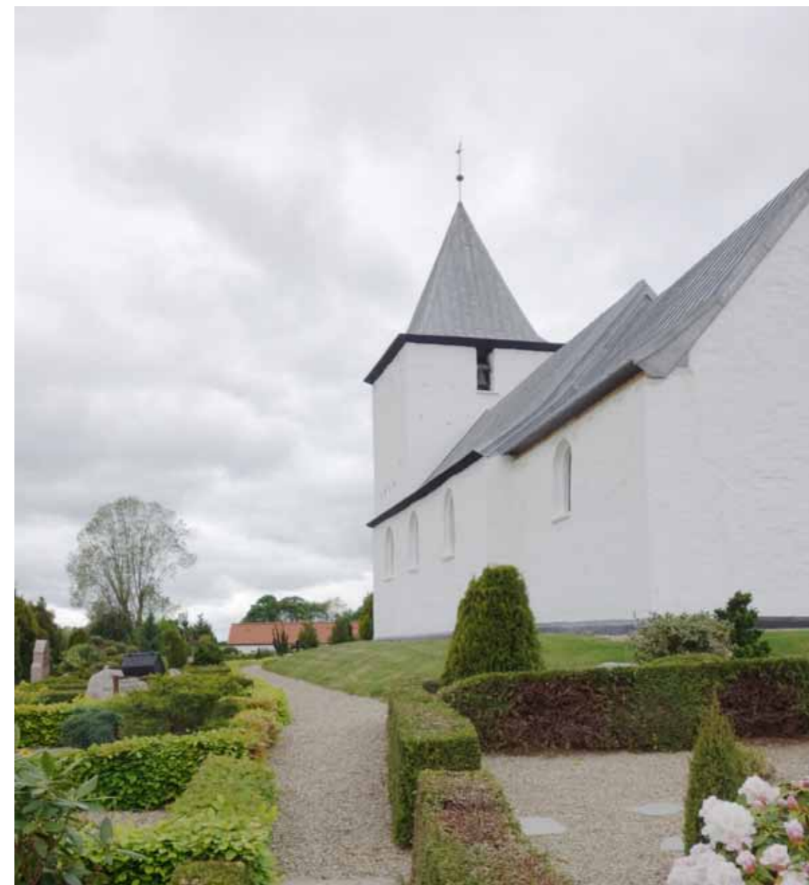
Kirken er smukt beliggende på en græsklædt banke
