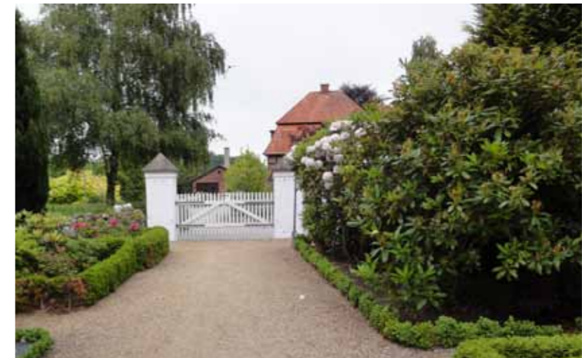
Eksempel på fast grussti afdækket med et tyndt lag perlegrus. Sdr. Vissing Kirkegård
